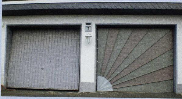
**Aus trist wird schick. Die strahlenförmig angeordneten Elemente der Garagentore bestehen aus konischen Zinkscharen.**
